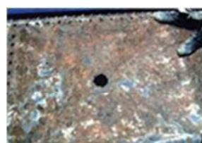
写真-2 水抜き穴の欠損 写真-3 BP腐食状態
