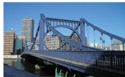
写真-1 清洲橋全景
