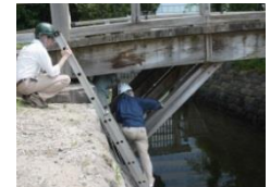
木橋の点検（浜）
