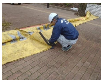
出水防止対策・ウォーターゲート (城北中央)
