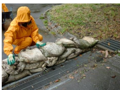
出水防止対策・土嚢 (木場)
