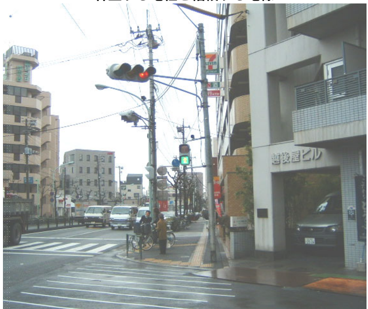
林立する電柱と輻輳する電線
