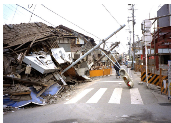
阪神・淡路大震災で倒壊した電柱
