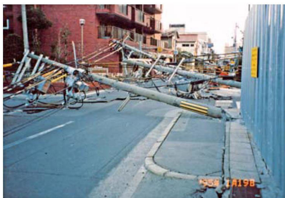
阪神・淡路大震災で倒壊した電柱
