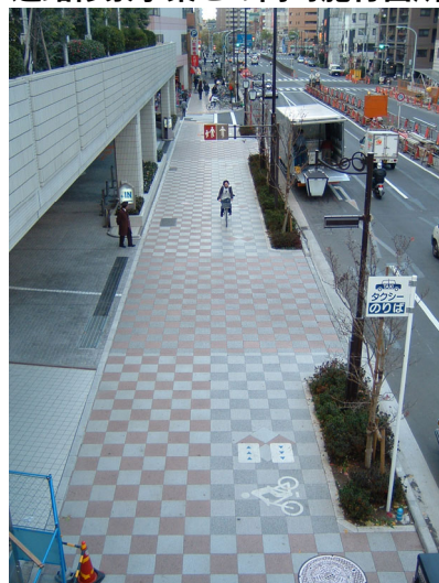
道路修景事業との同時施行箇所
