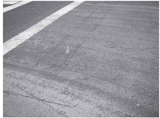
写真-4 骨材飛散
