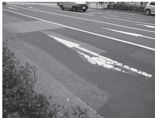
写真-10の1 部分補修
