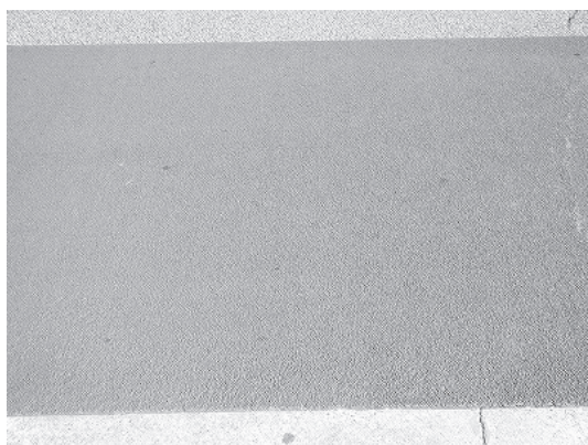
写真-9の2 すべり止め舗装
