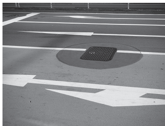
写真-10の2 部分補修
