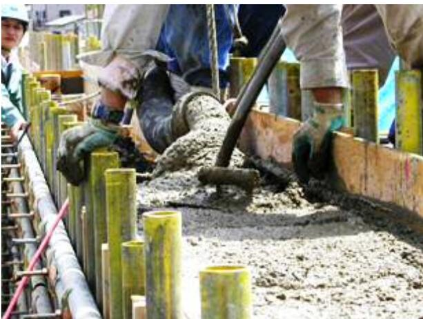
写真-4 今のコンクリート打込み状況
