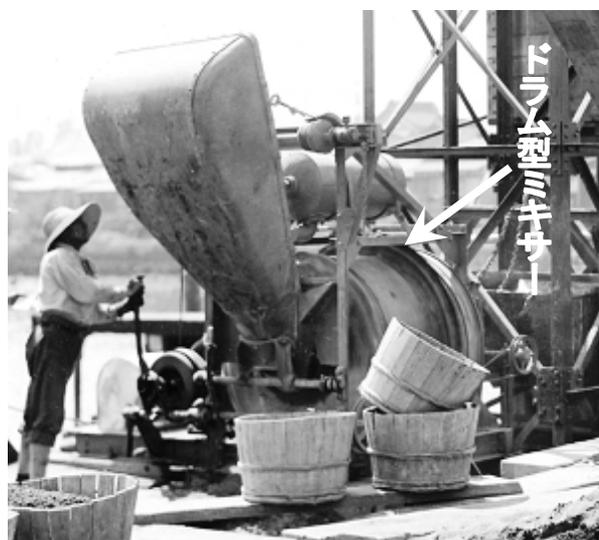
写真-1 コンクリートの練混ぜ (1926年)
