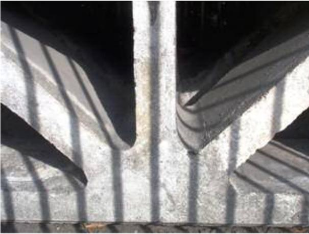
写真-9 トラス格点部分の詳細
