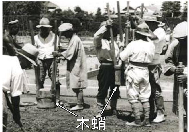
写真-5 コンクリート打込み状況 (1935年)
