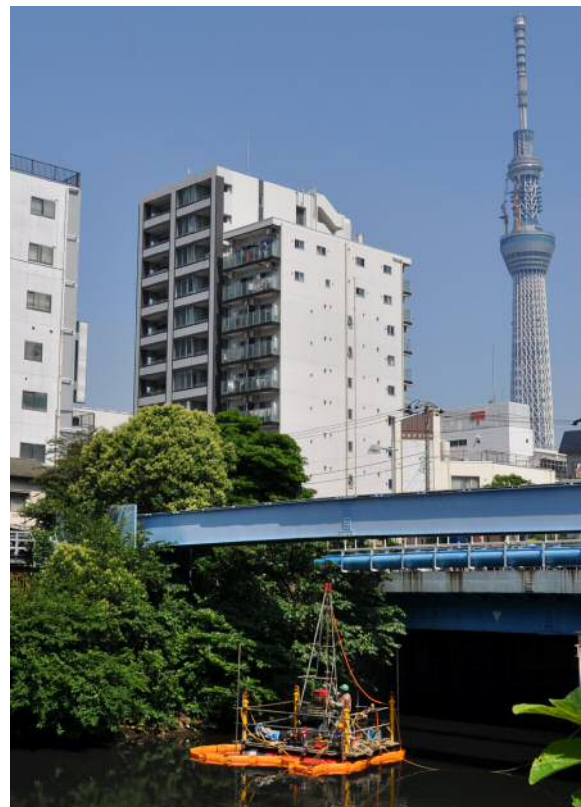
写真-1 横十間川・試料採取場所（天神橋下流） 水上ボーリング
