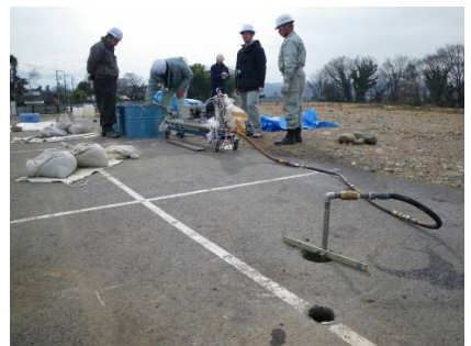
(d) 注入孔付近
