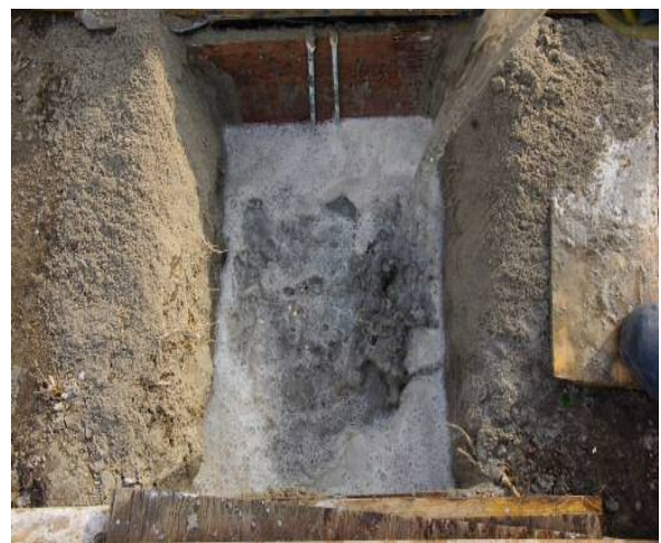
写真-1 水締めによる処理土の打設状況
