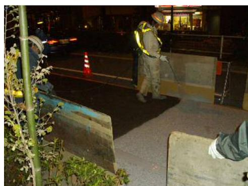
写真-5 遮熱材飛散防止の状況
