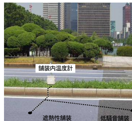
写真-7 観測状況（舗装内温度）
