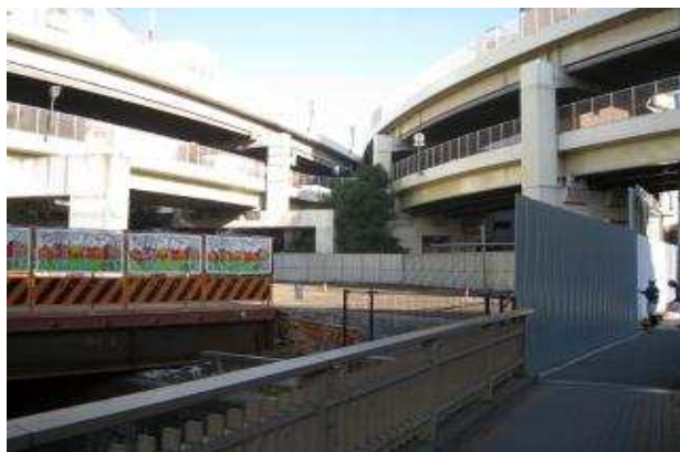
写真 - 4 古川地下調節池技術検討委員会への参画
