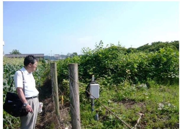
写真 2 地下水観測井・現地調査
