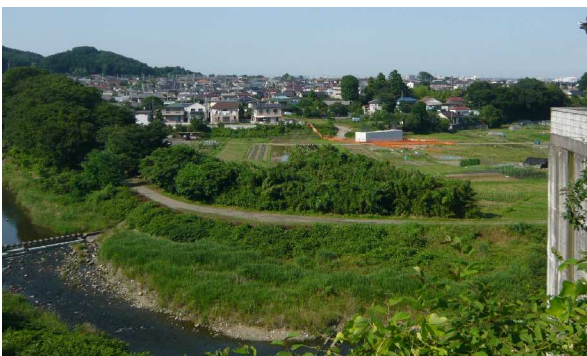
写真 1 架設地点周辺並びに左岸橋台状況
