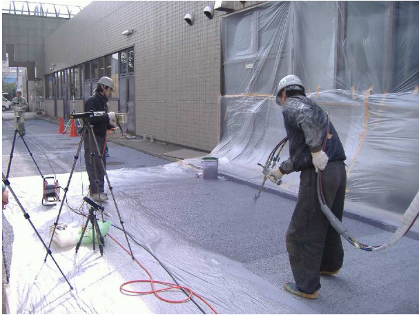
写真 - 2 構内臭気測定状況
