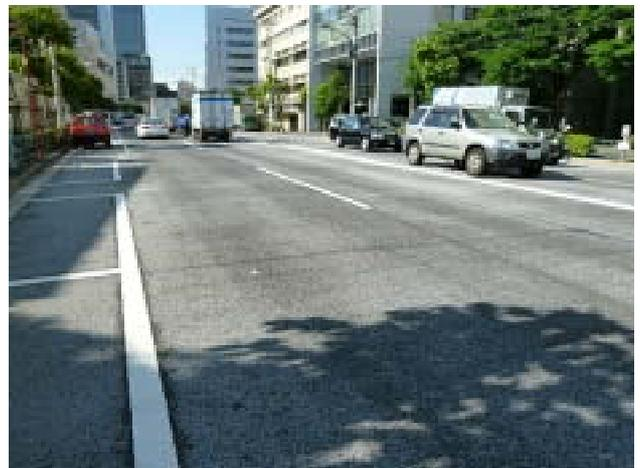
写真 - 6 遮熱材のはがれと摩耗が進行
