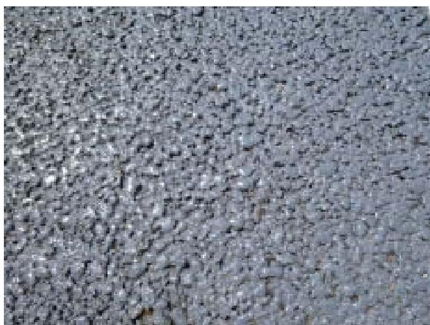
写真 - 1 すべり止め用骨材が摩耗し樹脂面が露出
