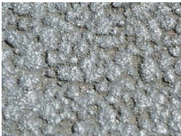
写真 - 2 すべり止め用骨材が摩耗し丸みを帯びる
