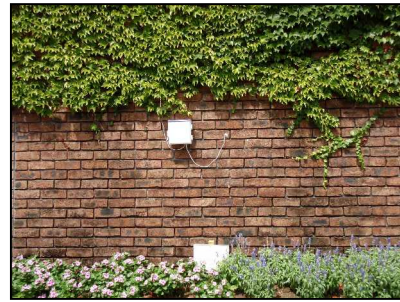
写真 - 15 壁面緑化温度測定状況 (2008 佃大橋)
