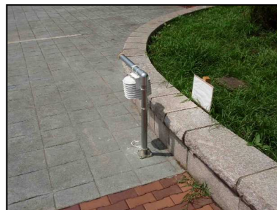
写真 - 6 堤外テラス温度計測状況(2008 佃大橋)
