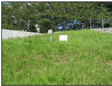
写真 - 12 芝生堤防温度測定状況（2007 桜橋）
