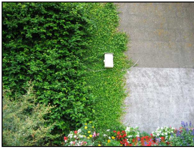
写真 - 14 壁面緑化温度測定状況 (2007 言問橋)
