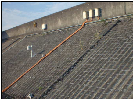
写真 - 1 中川堤防温度計測状況(2005年)
