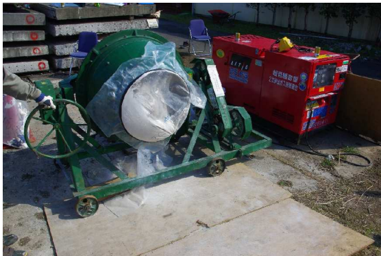
写真-1 ミキサーによる混合（飛散防止）
