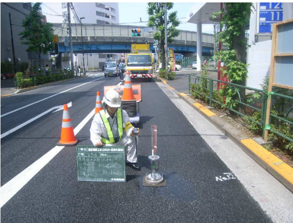
写真 - 4 舗装路面に対する現場透水量試験
