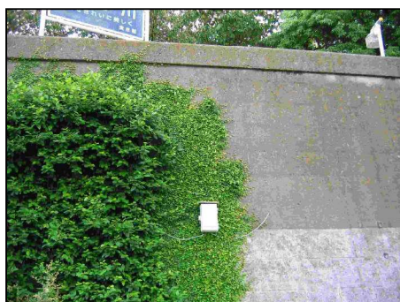
写真－4 隅田川言問橋下流右岸の壁面緑化
