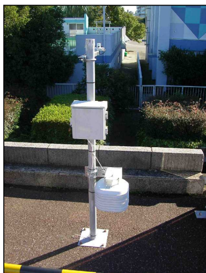
写真－2 堤防温度の計測状況
