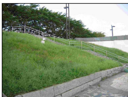
写真-3 隅田川桜橋下流右岸の芝生堤防
