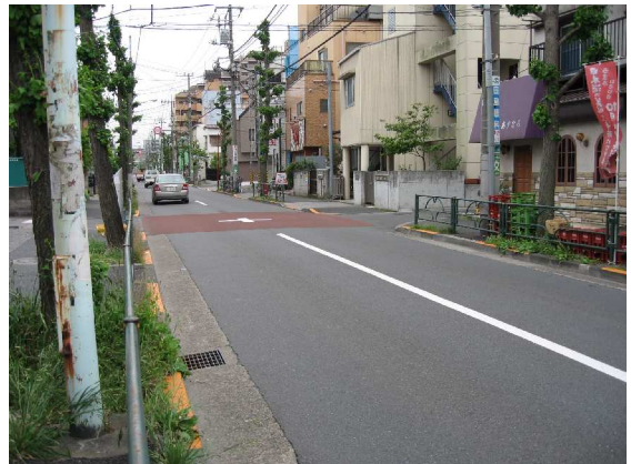
写真 - 1 A 工区(路面状況)
