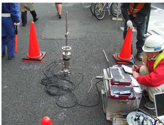
写真-1 小型 FWD によるたわみ量測定状況
