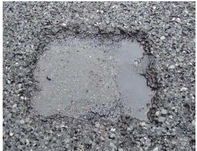
写真-12 材料C供用後翌日の沈下状況
