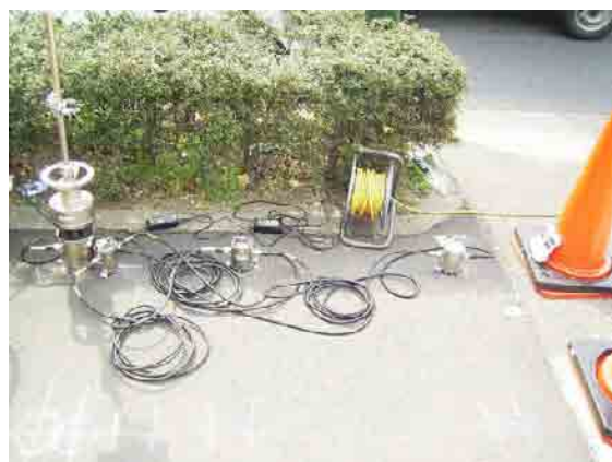
写真-1 No.2における小型FWD測定状況
