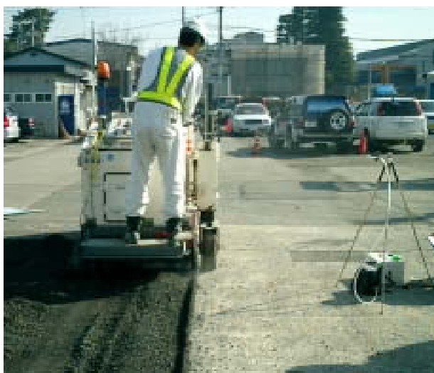
写真 - 2 切削状況および粉塵測定状況
