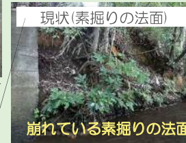
写真 新たな橋の下となる現状の法面
