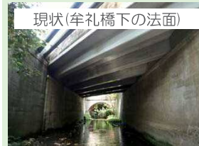
写真 現状の牟礼橋下の法面
