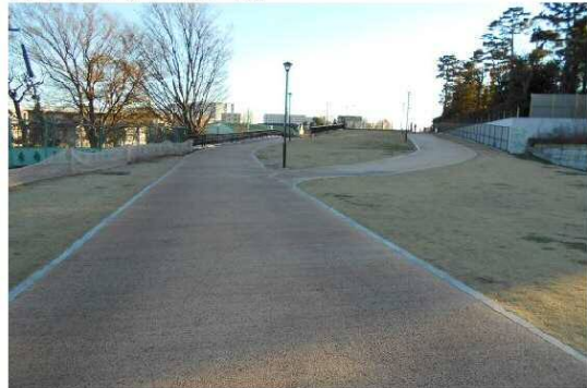
⑦トンネル上部園路
