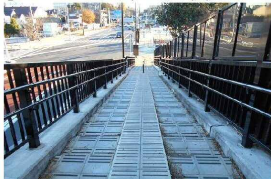
⑧階段（トンネル上部の園路へ接続）
