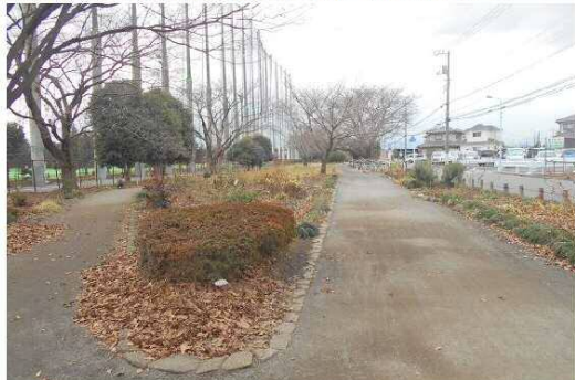
② 西武立川駅付近暗渠上部（北側左岸）
