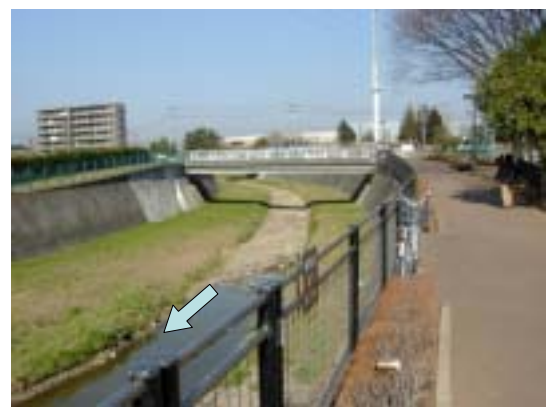
写真 2 - 2 改修後の残堀川 (立川市上砂町付近)
