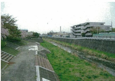
残堀川の階段護岸整備（武蔵村山市）
