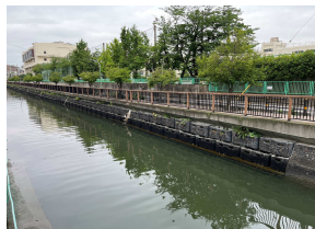
五之橋上流付近
