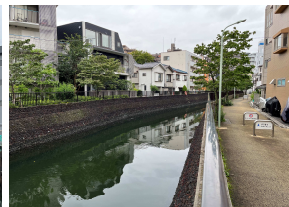
新橋上流付近
