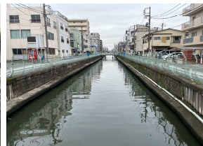
新田橋下流付近
