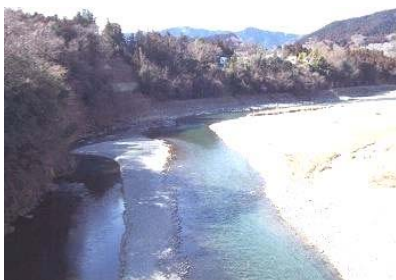
多摩川・万年橋上流 水衝部に護岸が整備されている
