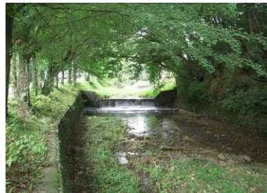
大荷田川 複数の落差工が設けられている
