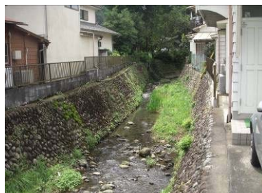
鳶巣川 市街地周辺の堀込河道
