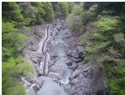
白丸ダムに設けられた魚道 延長 331mの魚道が設置されて いる
