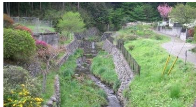
鳶巣川に設けられた ゲンジボタルの生息地整備箇所
