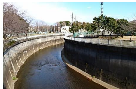
板橋区 栗原橋付近
