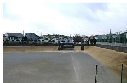
西東京市 向台調節池
