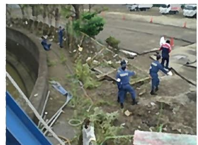
洪水による被害状況 北区溝田橋付近 (平成22年7月5日豪雨)
