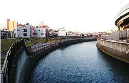
北区 あすか緑地付近 (高潮対策区間)
