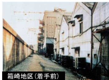
テラス整備事例
