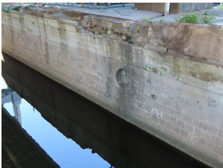
写真 2 - 9 古川の護岸が老朽化した状況
