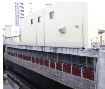
養老橋下流右岸取水口
