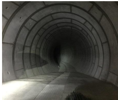
古川地下調節池内部
