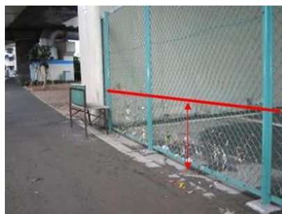
平成11年集中豪雨冠水痕跡 (明治通り)
