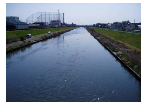
河床掘削箇所
