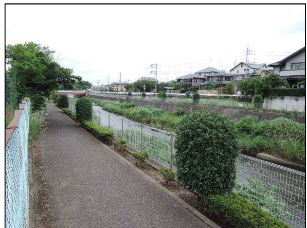
管理用通路の整備状況（根岸橋下流付近）
