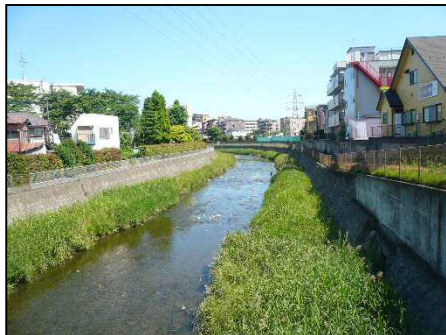
境川の河道の状況（幸延寺橋付近）
