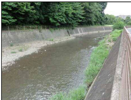
改修後の境川
