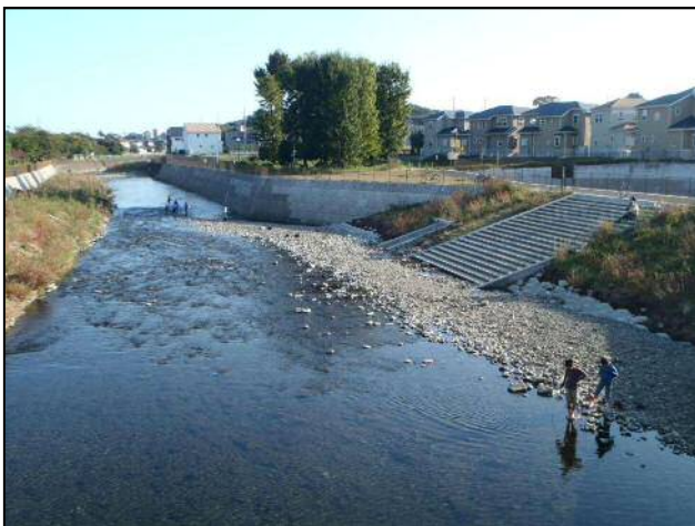
境川の親水整備（鶴間一号橋付近）
