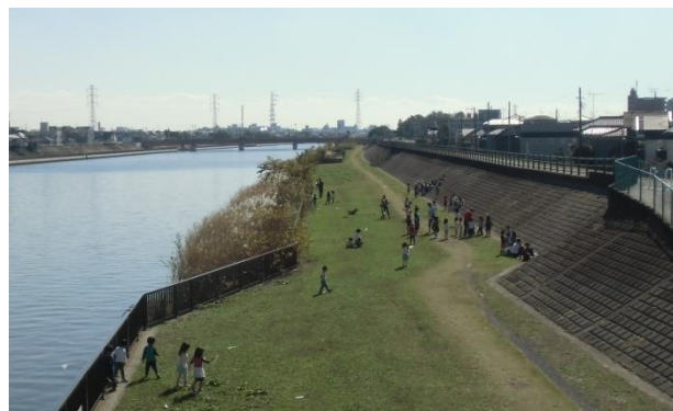
水辺の植生に配慮した護岸の整備 新中川(江戸川区上一色付近)
