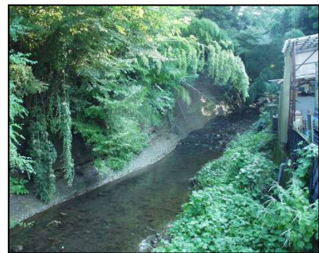
未改修区間の様子
