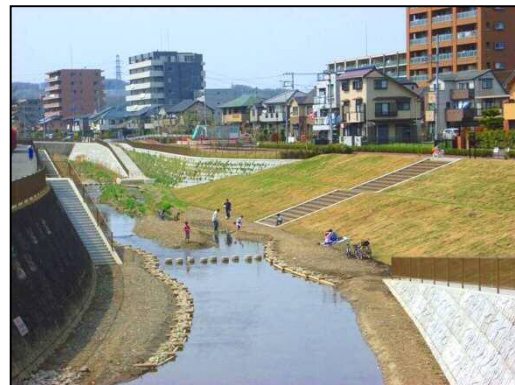
緩傾斜護岸の整備事例 (三沢川：稲城市矢野口)
