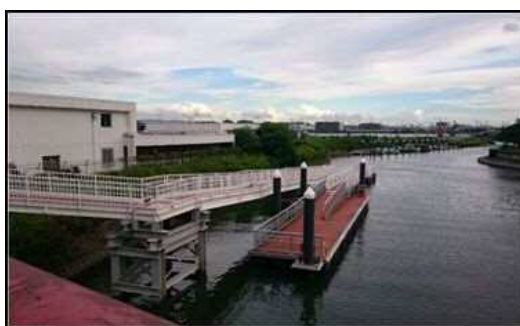
図 2-4 防災船着場（天空橋上流）
