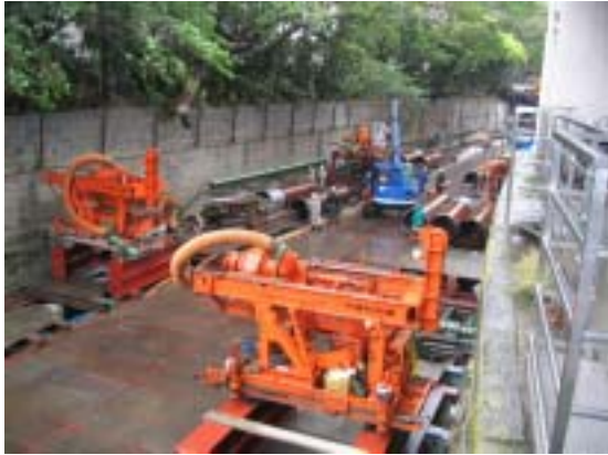
古川の護岸工事状況
