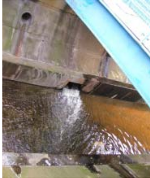
新並木橋付近の高度処理水放流口
