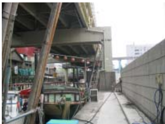
金杉橋下流（右側の擁壁が、再開発により設置された護岸）
