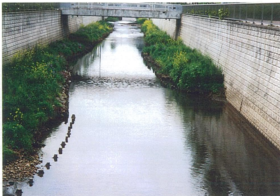
富士見橋より下流の状況
