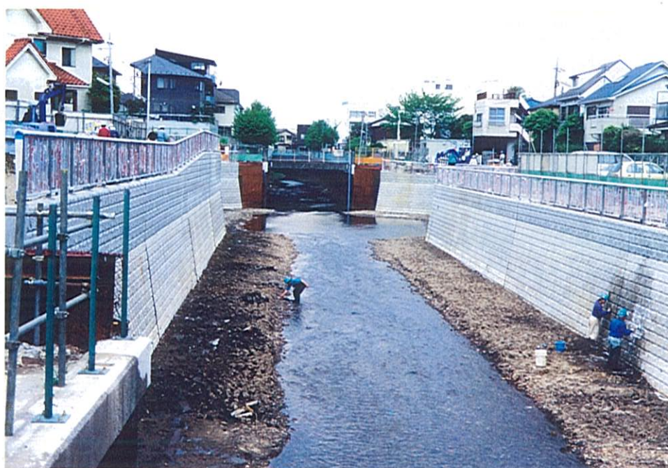
整備工事その131の状況
