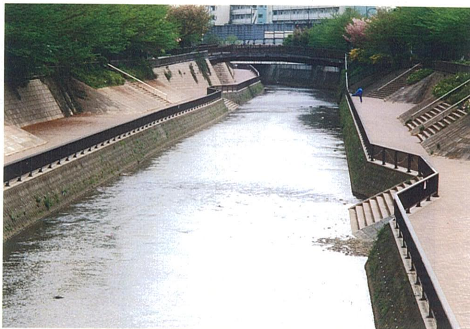
南田中橋付近の状況
