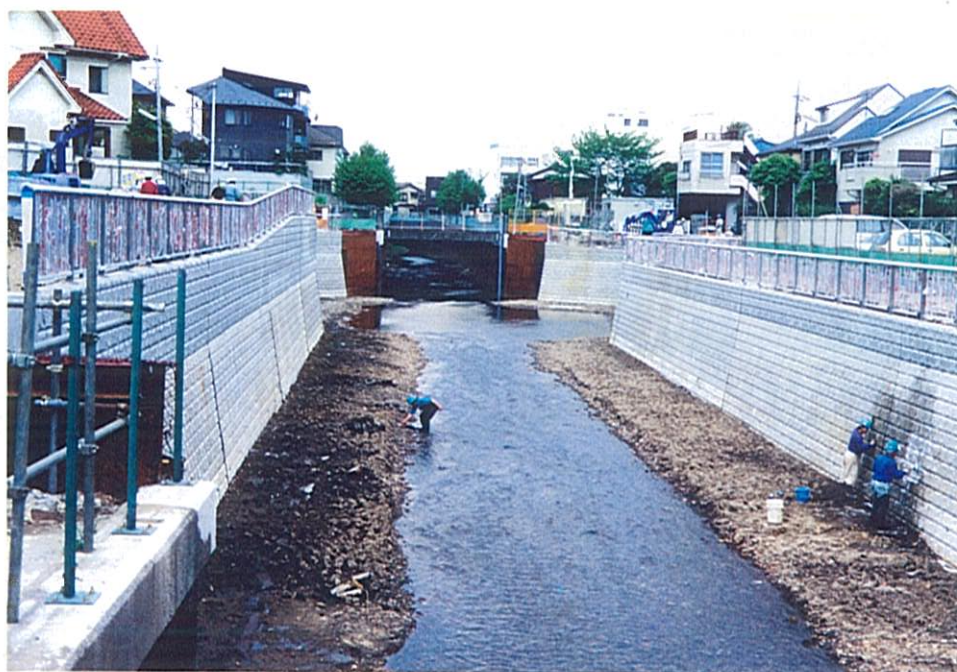
整備工事その131の状況
