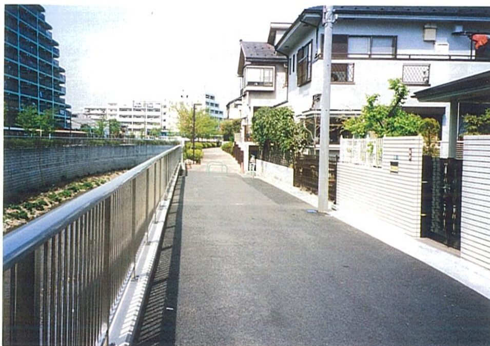
富士見橋下流右岸の状況
