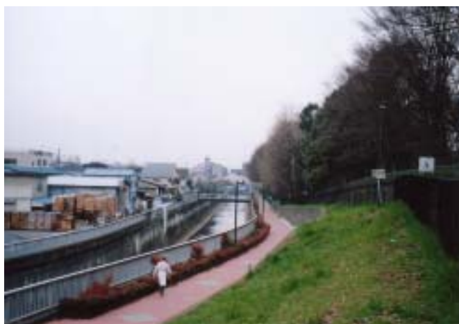
写真 4 - 8 城北中央公園付近現況写真
