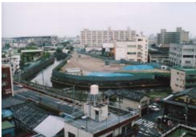
写真 4 - 6 あすか緑地付近首都高工事施工状況（平成 9 年当時）
