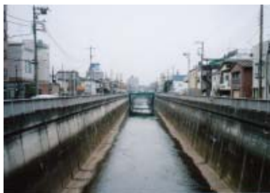
写真4 - 4 コンクリート三面張り既整備済箇所状況 (板橋区宮前橋下流)
