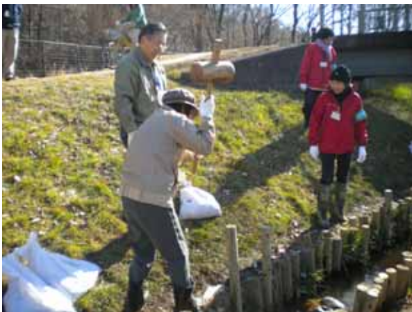
補修作業の説明（ほたる川）
