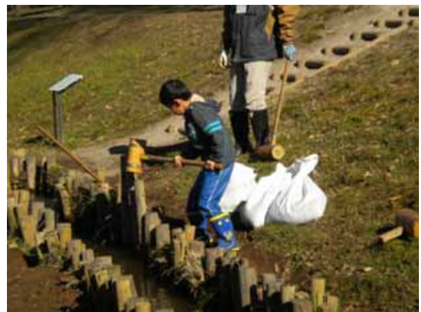
補修作業（ほたる川）
