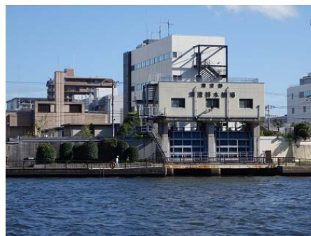
④清澄排水機場
