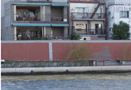
①テラス整備
