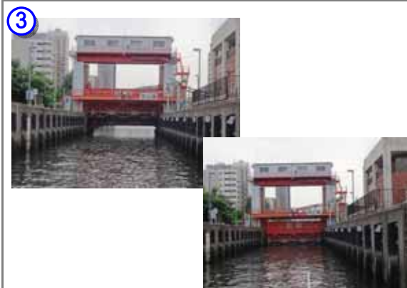
扇橋閘門を通過
