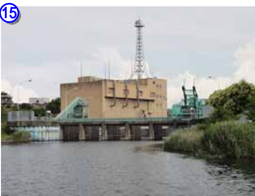
木下川排水機場
