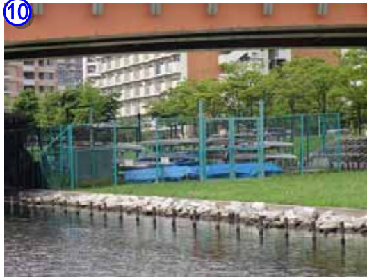
橋梁下の艇庫
