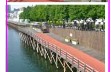
横十間川の木道テラスを歩いて川を視察。
