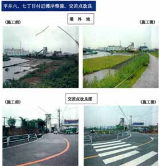
河川工事にあわせて堤防沿いの道路改良を実施しました。
