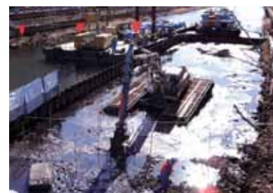
固化処理状況
