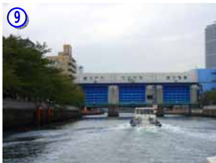
9 小名木川と隅田川の間の新小名木川水門。平常時は開いていますが、高潮や大地震時は閉鎖して水害を防ぎます。
