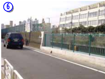
6 水位低下した小名木川の背面状況。整備により既設護岸を撤去しています。
