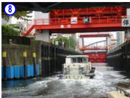
8 扇橋開門。ここで、小名木川の東側と西側の水位差を調節して船を通します。
